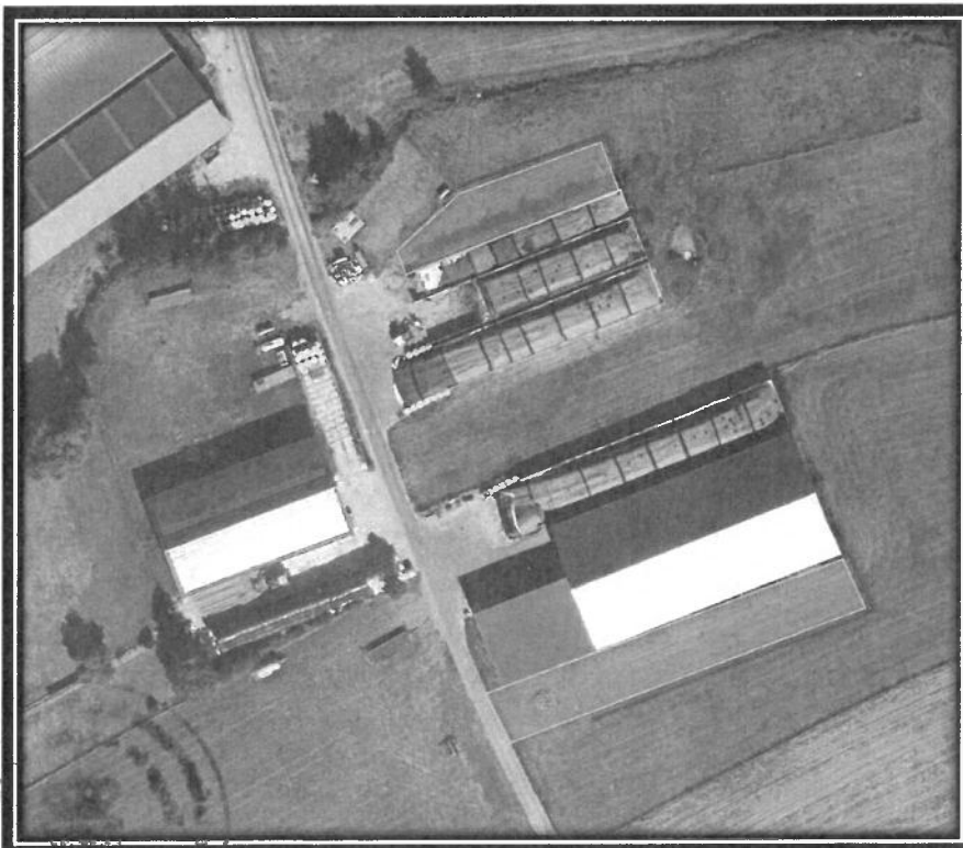
Situation prévue : Constructions en jaune / Mesures compensatoires en rouge (point= arbre, line=haie)
